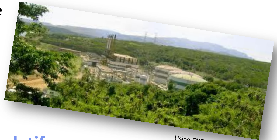
Usine ENERCAL à Poya
