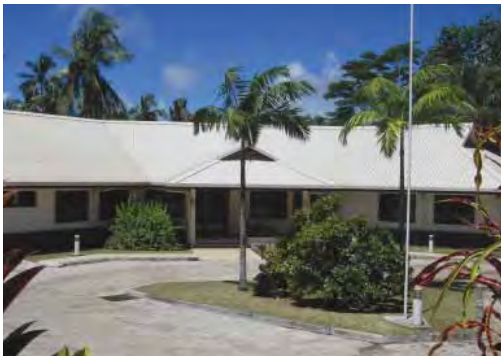
Bâtiment de l'IEOM et de l'AFD à Mata'Utu - Wallis - Photo : J. Delalande
