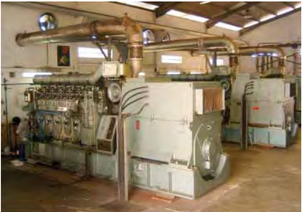
Centrale électrique - Wallis - Photo : EEWF
