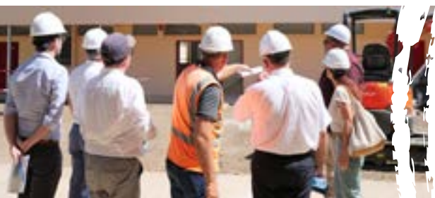
Rénovation du lycée Jules Garnier à Nouméa, en Nouvelle-Calédonie © GNC (Gouvernement de Nouvelle-Calédonie)
