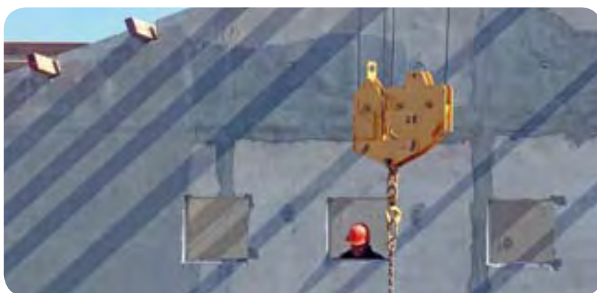
Nouvelle-Calédonie, Nouméa : Construction de logements, « Coteau des oliviers »
