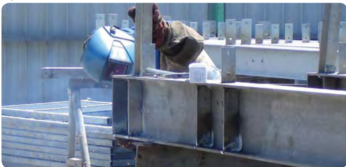
Nouvelle-Calédonie, Nouméa : Soudure d'une charpente métallique
