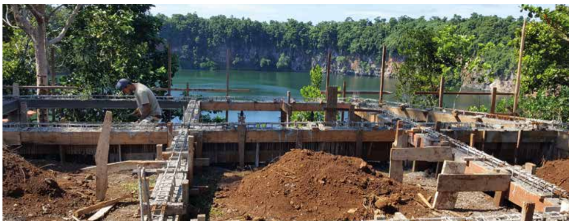
Wallis-et-Futuna. Chantier du belvédère du lac Lalolalo. Le projet du belvédère du lac Lalolalo s'inscrit dans le cadre du développement touristique et culturel du territoire de Wallis-et-Futuna. Cette construction a été financée par le contrat de développement 2012-2018 et s'est achevée en septembre avant la venue du navire de croisière L'Austral de la Compagnie du Ponant. Il proposera l'accès à un belvédère sécurisé offrant une vue panoramique sur le site remarquable du lac volcanique de Lalolalo. © Service des Travaux publics de Wallis-et-Futuna
