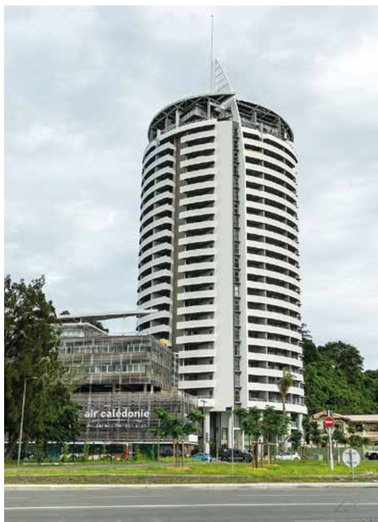
Nouvelle-Calédonie. Pacific Plaza à Nouméa (centre-ville). © Daniel Maviet
