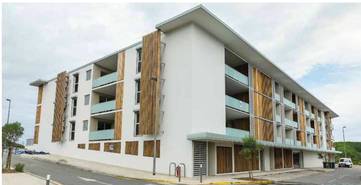
Nouvelle-Calédonie. Logement « L'Empuria », Nouville. © Daniel Maviet
