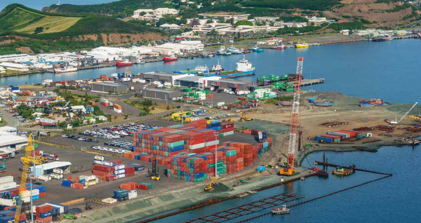
Nouvelle-Calédonie (Nouméa). L'extension du port autonome, début de remblai du poste à quai n°8. © PANC, Marc Le Chelard
