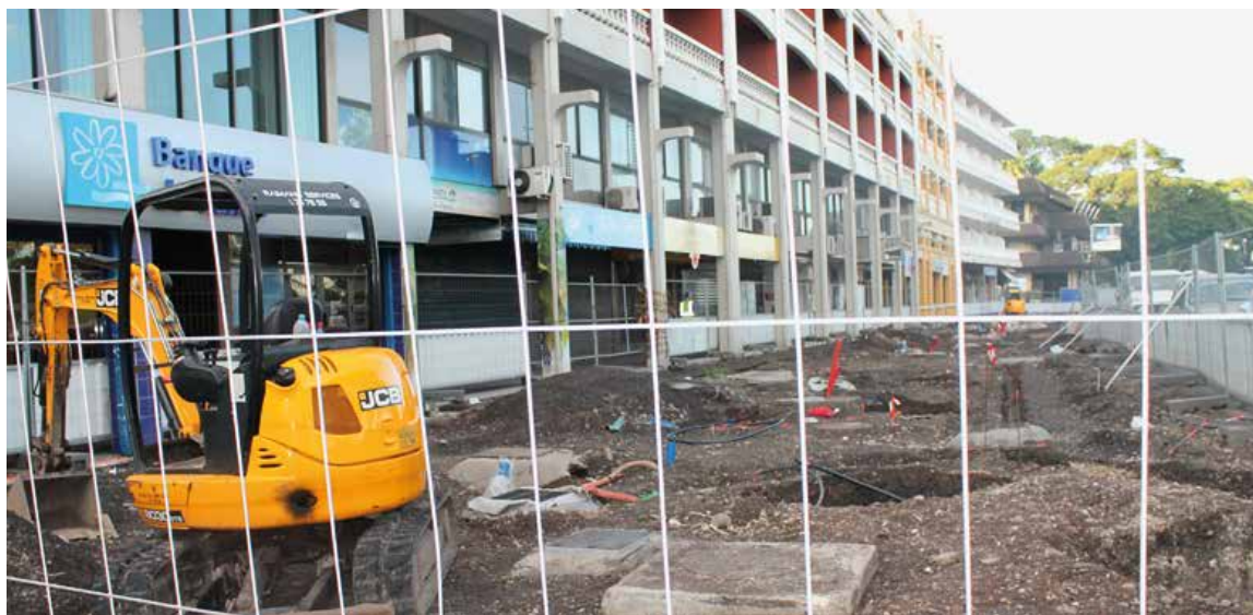
Polynésie française (Tahiti). Travaux de réfection de la chaussée du front de mer de Papeete. © N. Dupont-Teaha
