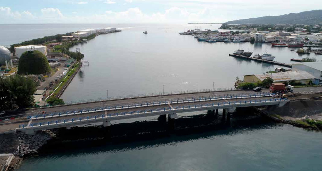
Polynésie française. Nouveau pont de la zone portuaire de Motu Uta. © Port autonome de Papeete
