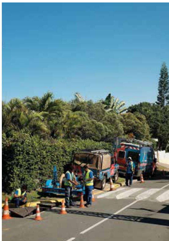
Nouvelle-Calédonie. Déploiement de la fibre optique. © OPT-NC
