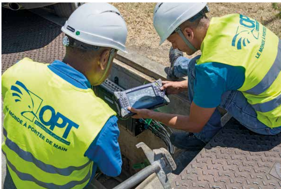
Nouvelle-Calédonie. Raccordement à la fibre optique. © OPT-NC
