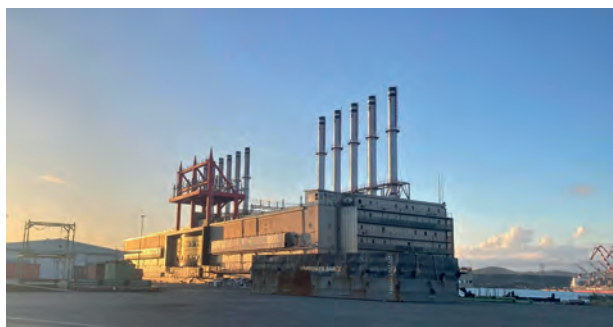
La centrale accostée temporaire à quai (Véronika Klasa, IEOM).
