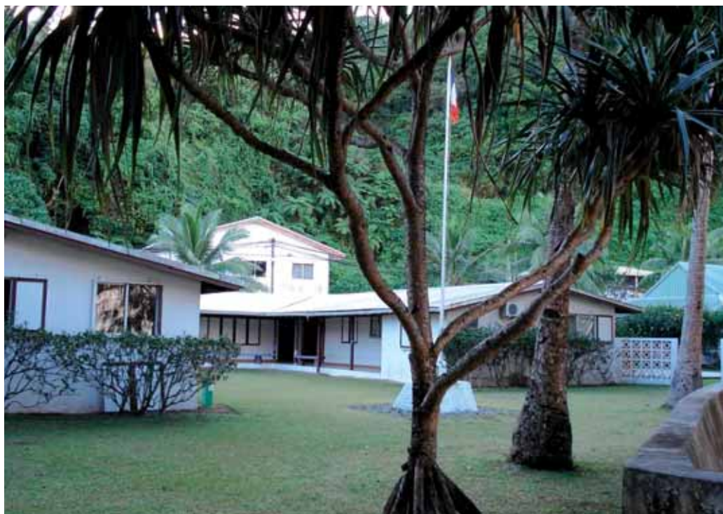
Locaux de la Délégation à Futuna - Photo : JM. GIVRE
