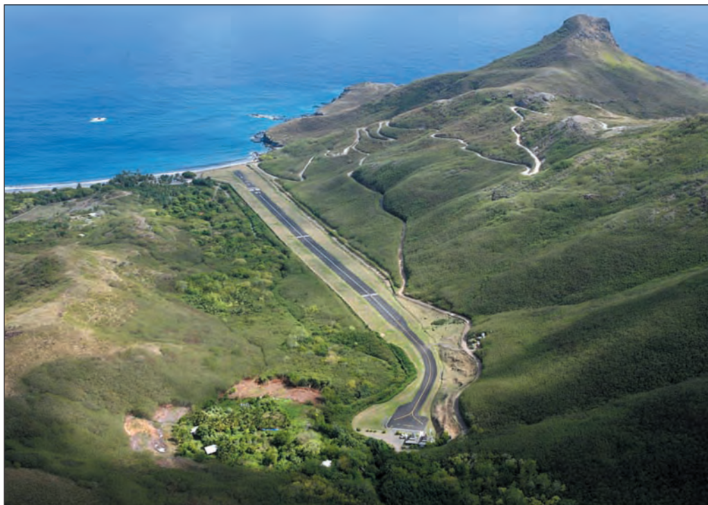
Ré novation de la piste de Ua Pou, Marquises
