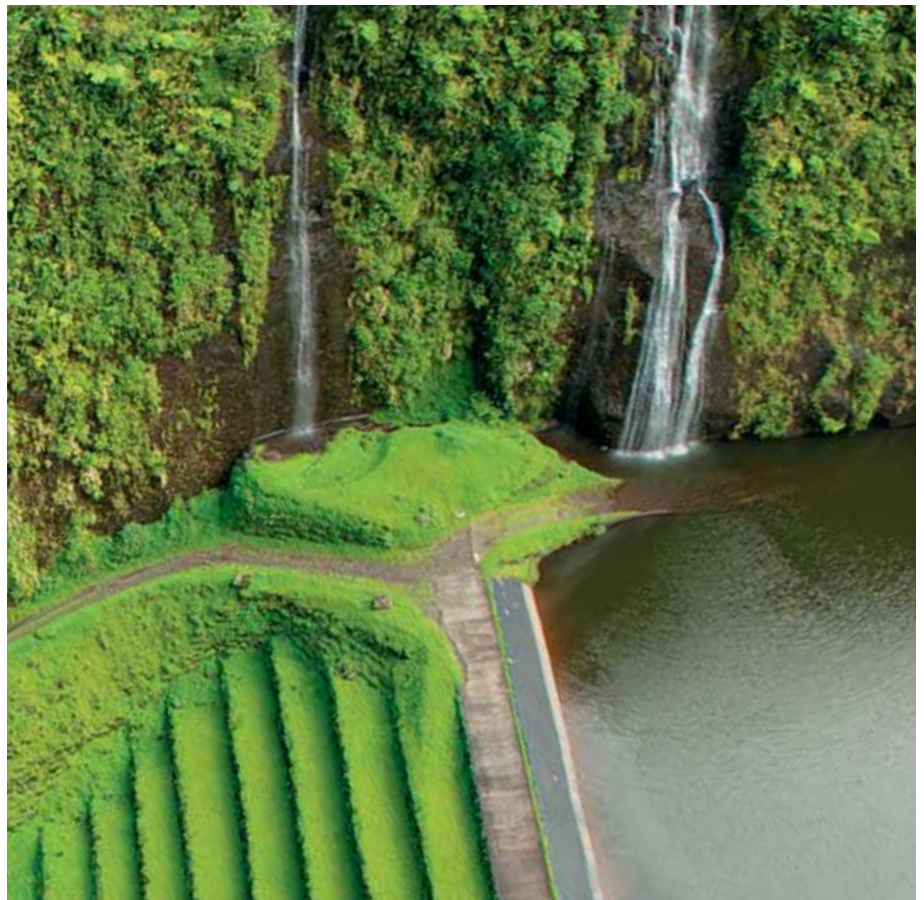
Polynésie française. Ouvrages hydroélectriques de Marama Nui, filiale de EDT, GDF SUEZ – Vallée de Titaaviri. © Tim McKenna
