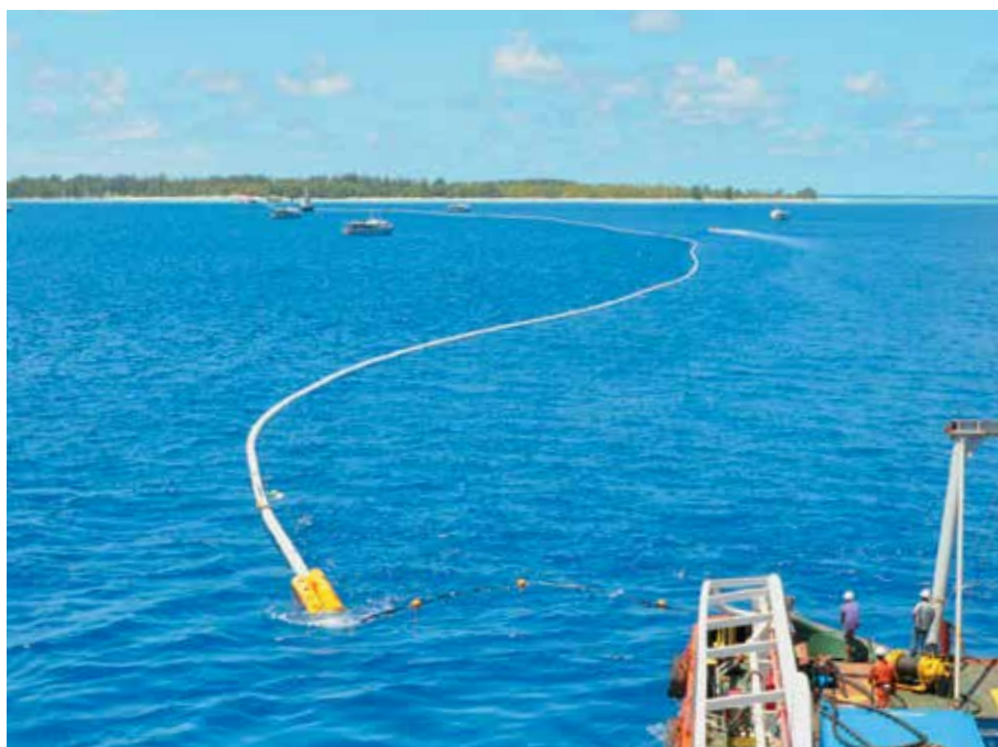
Polynésie française. Arrivée du pipeline d'aspiration sur Tetiaroa. © SWAC
