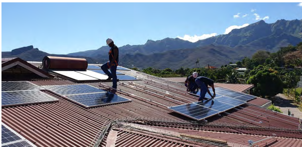
Installations photovoltaïques autonomes (avec batteries) en cours de pose à la cantine et la mairie de Taiohae, Nuku Hiva (îles Marquises).
