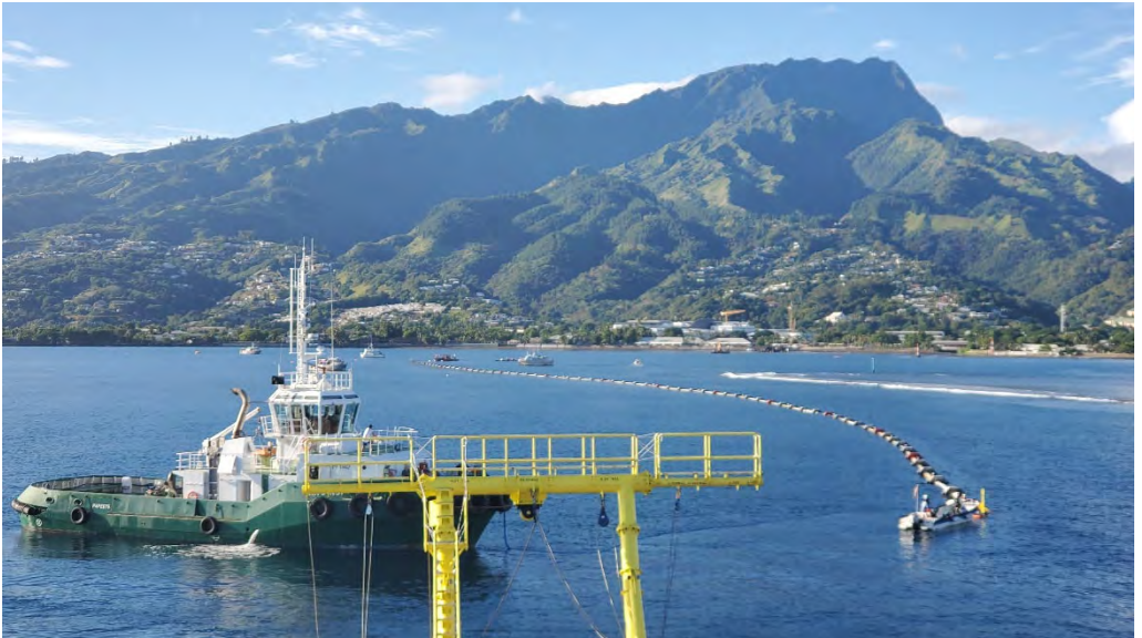
Coulage des canalisations maritimes du SWAC du Centre hospitalier de Polynésie française (CHPF) © Géocean, Service des énergies
