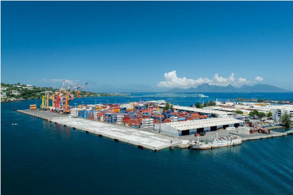
Zone portuaire de Motu Uta, d'une superficie de 3000 mètres de quais et de pontons, dont un quai au long cours destiné aux navires de commerce du type porte-conteneur ou cargo. ©Port autonome de Papeete
